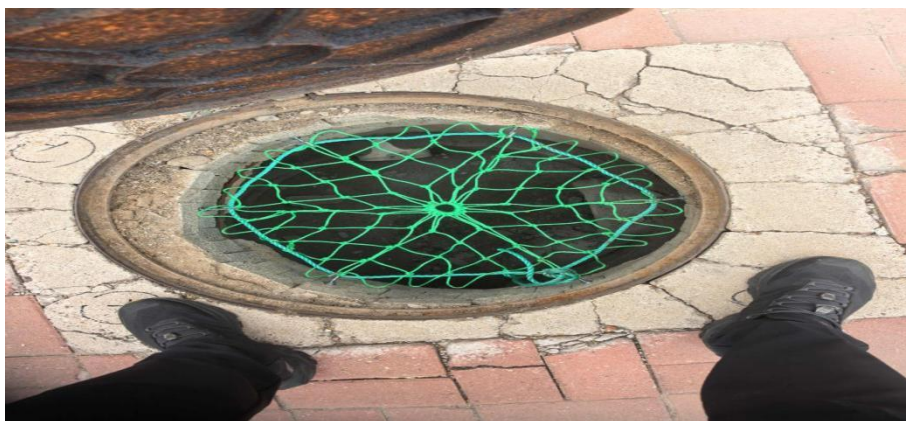
图 1-6 学校铺设防坠落网
