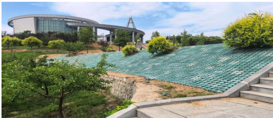
图 1-5 学校铺设防水土流失绿化砖
